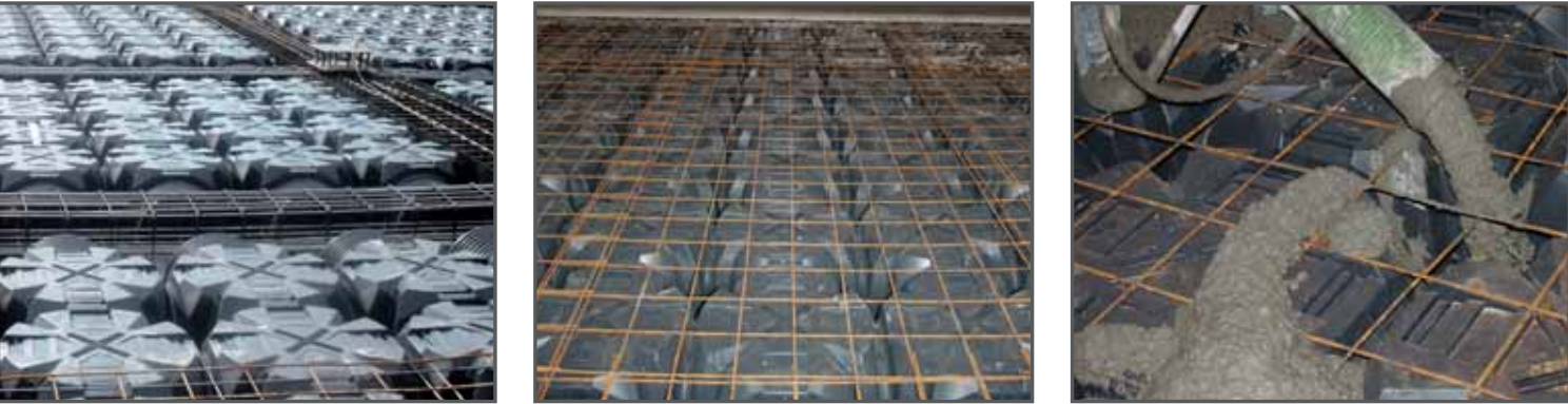
É possível ajustar a extensão de Geoblock deslizando-o sob o Modulo .
