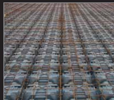
fig. 6) colocação da rede eletro-soldada
