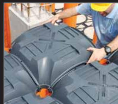
fig. 3) colocação das **COFRAGENS ELEVETOR®**
