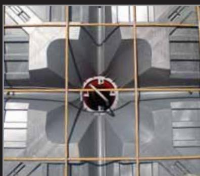
fig. 7) armação dos pilares com forquilha
