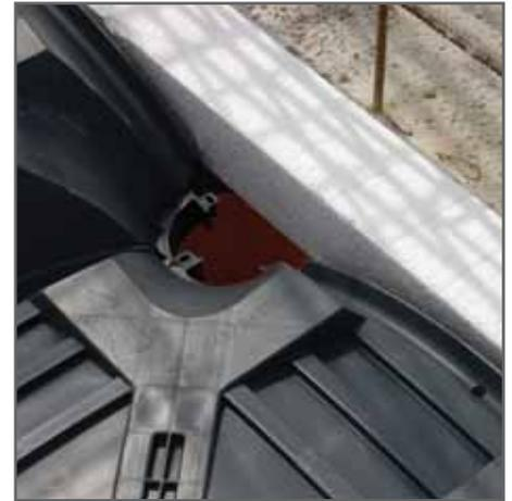
Detalhe do apoio da cofragem cortada sobre a prateleira de madeira fixada sobre a viga de fundação
