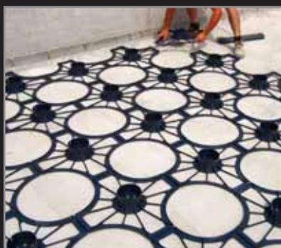
fig. 1) colocação da **BASE ELEVETOR®**
