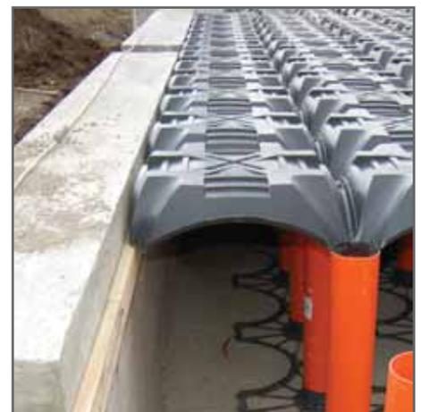
Detalhes sobre a plataforma de apoio elemento cortar viga de madeira fixado sobre a fundação
