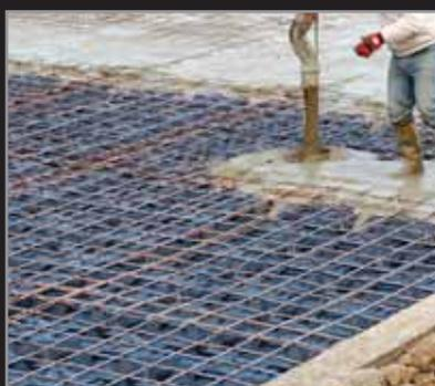
fig. 8) ase de betonagem
