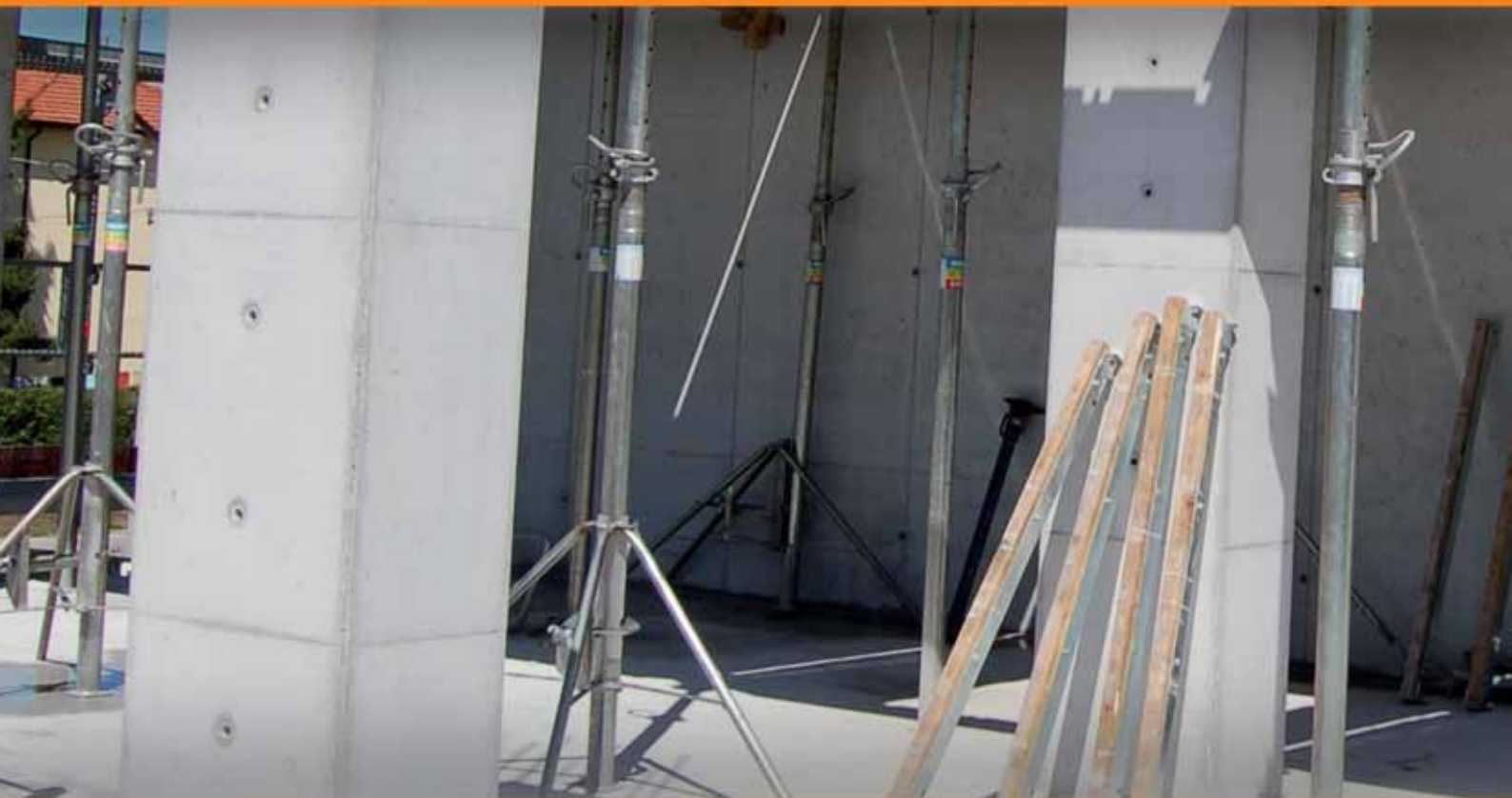
Cofragem reutilizável modular para pilares
