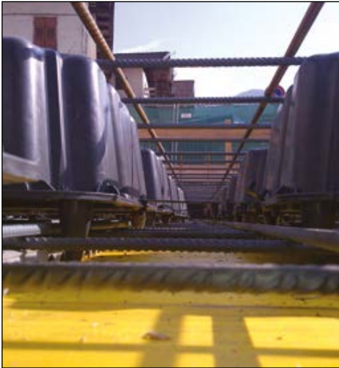
Utilidade das pontas inferiores para criação da laje inferior
