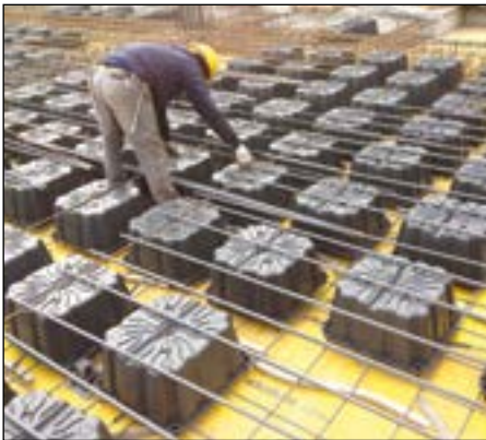
④ COMPLETAMENTO ARMADURA
