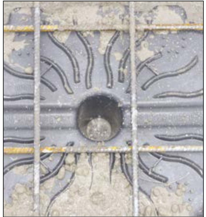
Controle visivo do completamento efetivo da laje inferior
