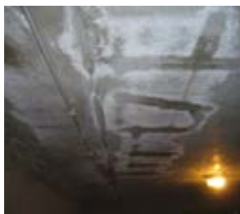
Infiltração de água
