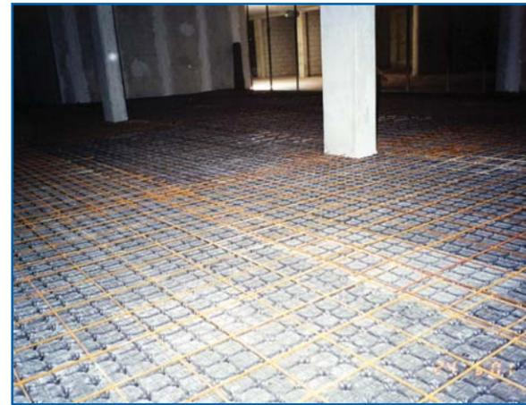
El **MINIMODULO** permite una ventilación natural o forzada sobre toda la superficie con dispersión de gas **RADÓN**.
