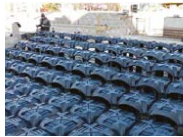
Detalhe do posicionamento das cofragens
