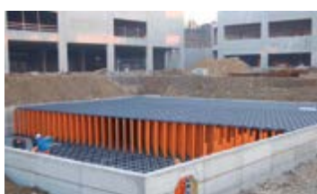
Tanques de acúmulo de águas meteóricas até 300 cm
