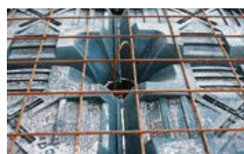
Reforço do pilar com armação
